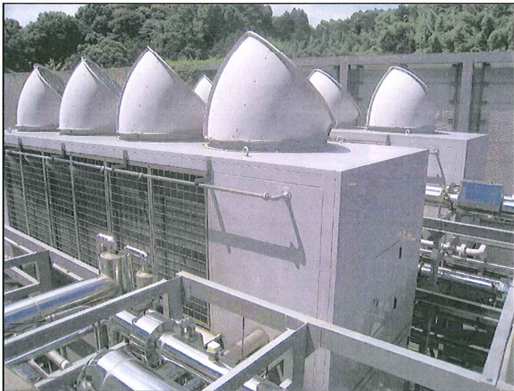
写真 1 機器の設置状況
