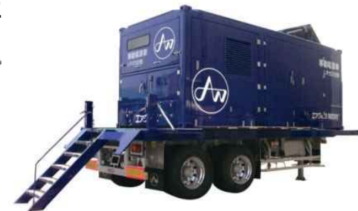
コンテナ(100kW級)タイプ
