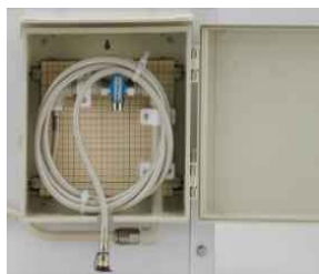
専用ガス供給 ボックス
