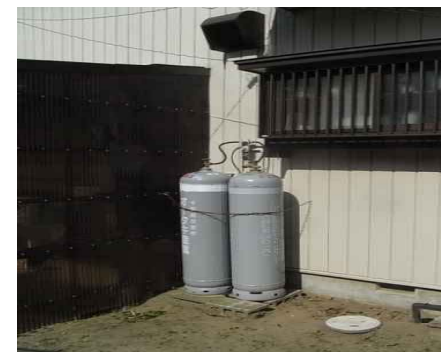
軒下に50kgの ガスボンベ
