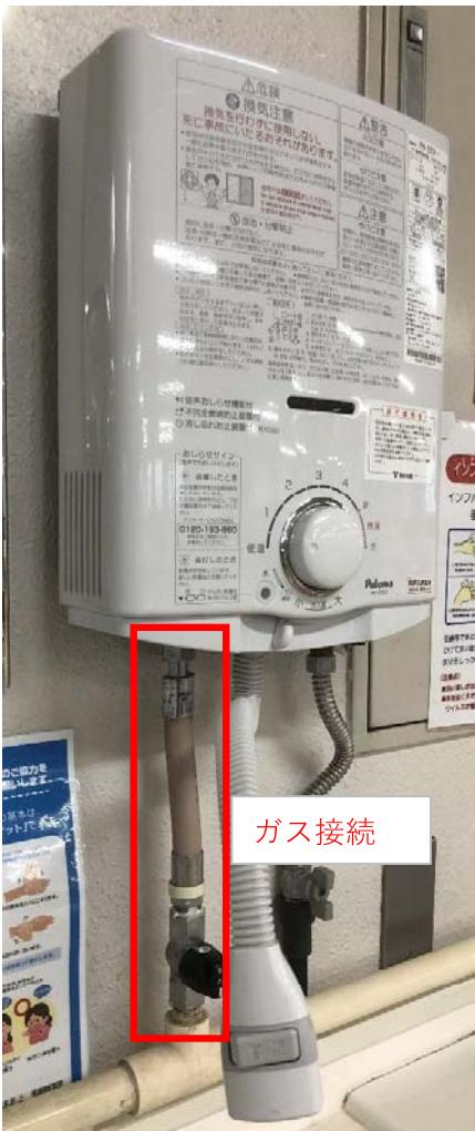
小型湯沸器とガス栓とのガス接続について、以前使用していた小型湯沸器の「ゴム管口」を再使用しゴム管接続する事例が見受けられます。
