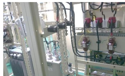
受電設備の2次側配線
