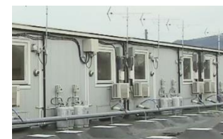
仮設住宅へのLPガス設置
